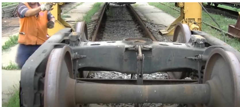
Рис. 1.19. Підйом кузова вагона (а) на 4-ох домкратах; викочування візків (б).
